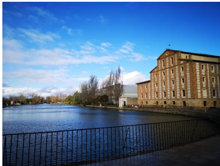
Muelle del Canal de Castilla en Medina de Rioseco (Valladolid)
